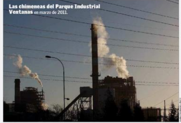
Las chimeneas del Parque Industrial Ventanas en marzo de 2011.
