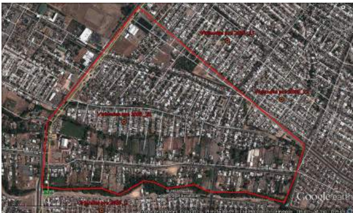
Figura G7 Sector n°6 Zona Sur Fuente: GoogleEarth 2013
