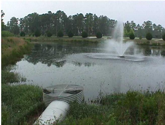
Figura 112. Tranque de retención con bomba de aireación. Fuente: Natural Resources Conservation Service. Fuente: <http://www.nrcs.usda.gov/>
