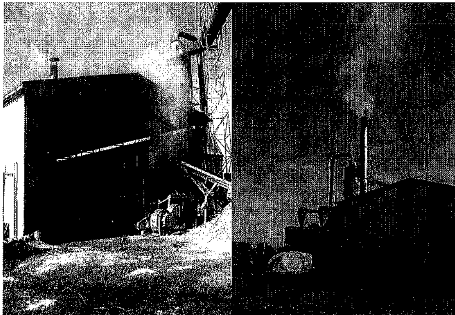
Figura 4: Caldera industrial de antehogar, con emisiones visibles por chimenea y fugitivas.
