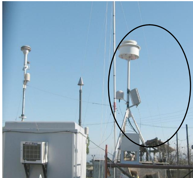
Figura 8.1. Equipo Super SASS instalado en Hogar de Ancianos de Ventanas.
