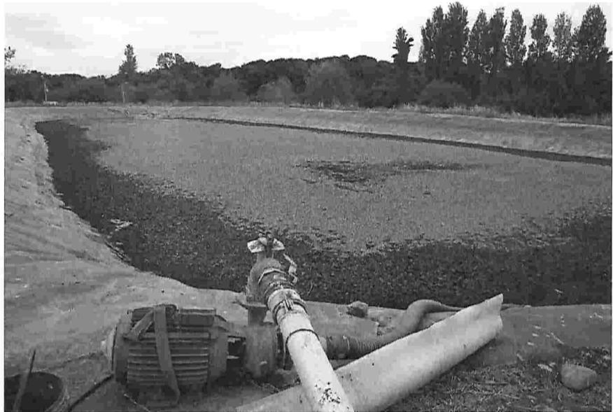
Ejemplo de laguna de tratamiento anaeróbico con contenido de purines.
