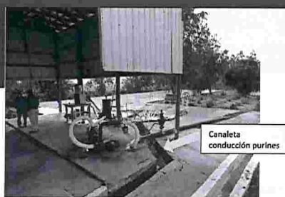
Canaleta de conducción de purín Fuente: http://snifa.sma.gob.cl/v2/Fiscalizacion
