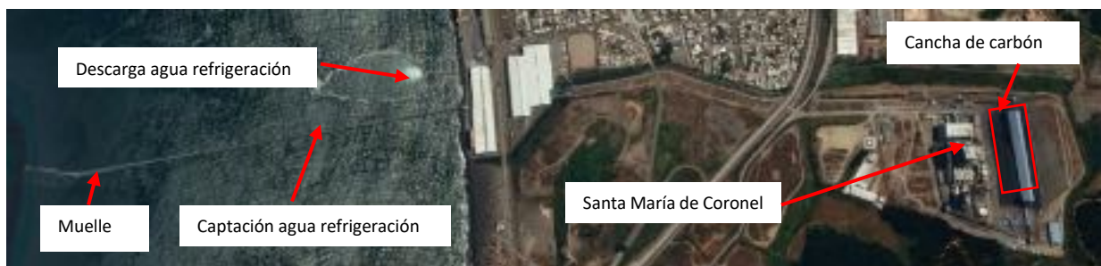
Figura 28: Complejo termoeléctrico Santa María. Fuente: Elaboración propia.
