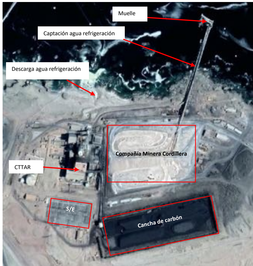
Figura 21: Central Térmica Tarapacá. Fuente: Elaboración propia.
