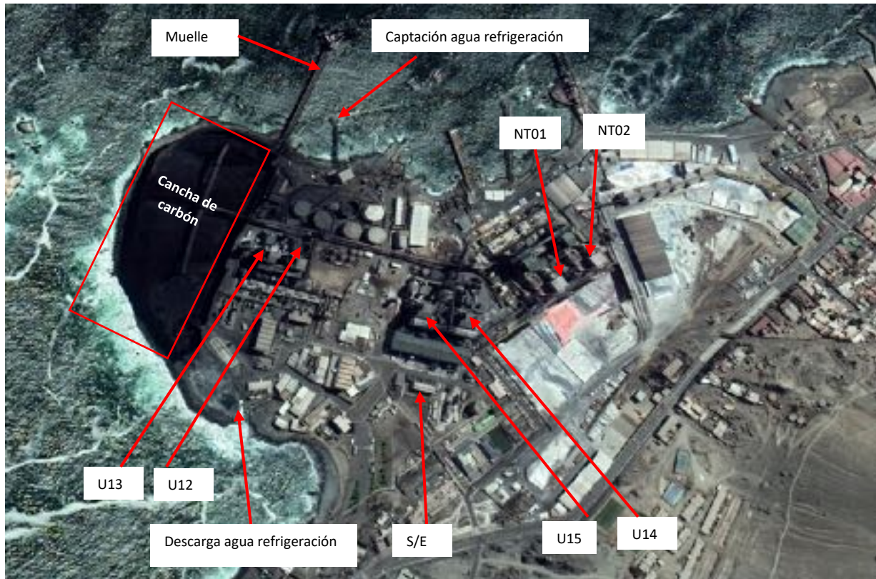
Figura 22: Complejo termoeléctrico Tocopilla – Nueva Tocopilla. Fuente: Elaboración propia.
