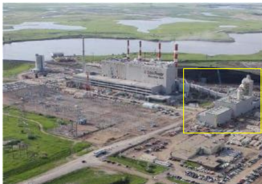
Figura 5.2.4. Foto de la Central Boundary Dam de SaskPower, donde se ve a la derecha (recuadro amarillo) la planta Cansolv de captura de SO 2 y CO 2 [90].
