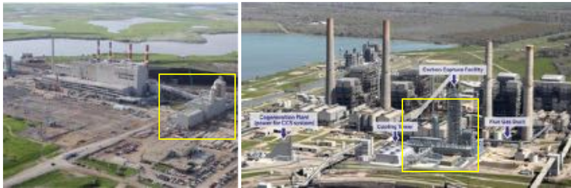
Figura 42: Centrales Boundary Dam y WA Parish con sus plantas de captura de CO 2 en recuadros amarillos. Fuentes: Power Technology y EIA.
