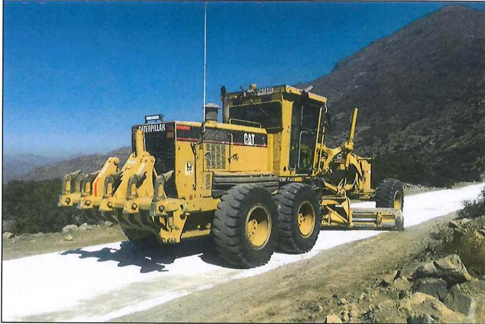
Figura 3: Homogenización de RoadSalt con motoniveladora
