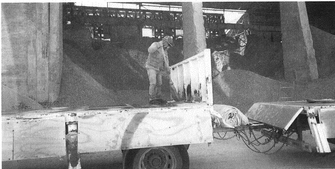
**Fotografía 4.** Tarea de barrido en ejecución, del material acumulado entre ambas superficies con el material remanente humectado parcialmente.
