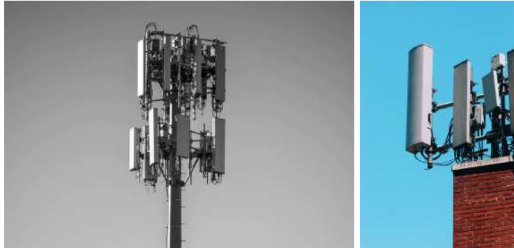
Fig 1.11- Ejemplos de estaciones bases instaladas en torres dedicadas y edificios.
