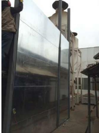
Figura 100: Barrera acústica de panel acero galvanizado microperforado,  $R_w 38$ . Fuente: ACR Acústica.
