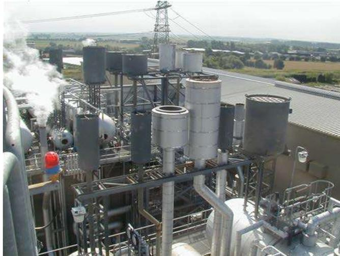
Figura 104: Silenciadores de escape o venteo tipo Fuente: BBM Akustik Technologie.
