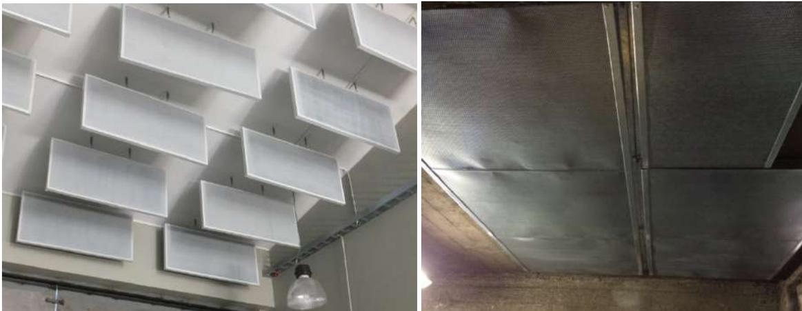
Figura 106: Panel absorbente acústico tipo QP-50. Fuente: ACR Acústica.
