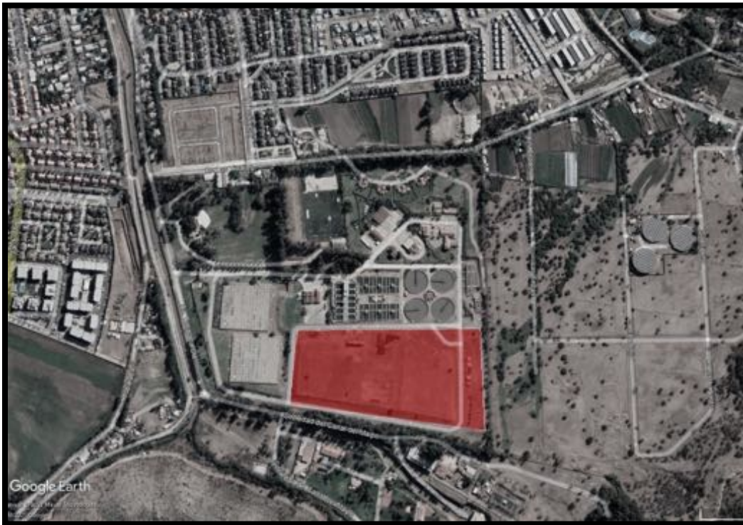
Figura 2. PTAP La Florida y área de emplazamiento sistema de tratamiento de lodos.
