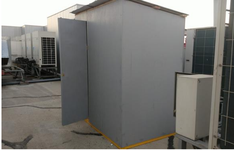
Figura 1.9: Caseta en la azotea del edificio de investigación.
