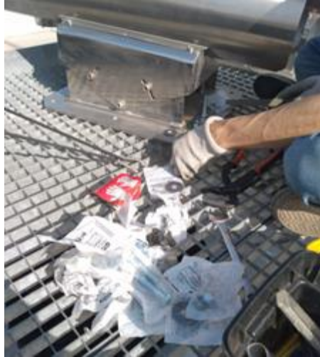
Figura 1.7: Fijación del equipo emisor con golillas a la plataforma
