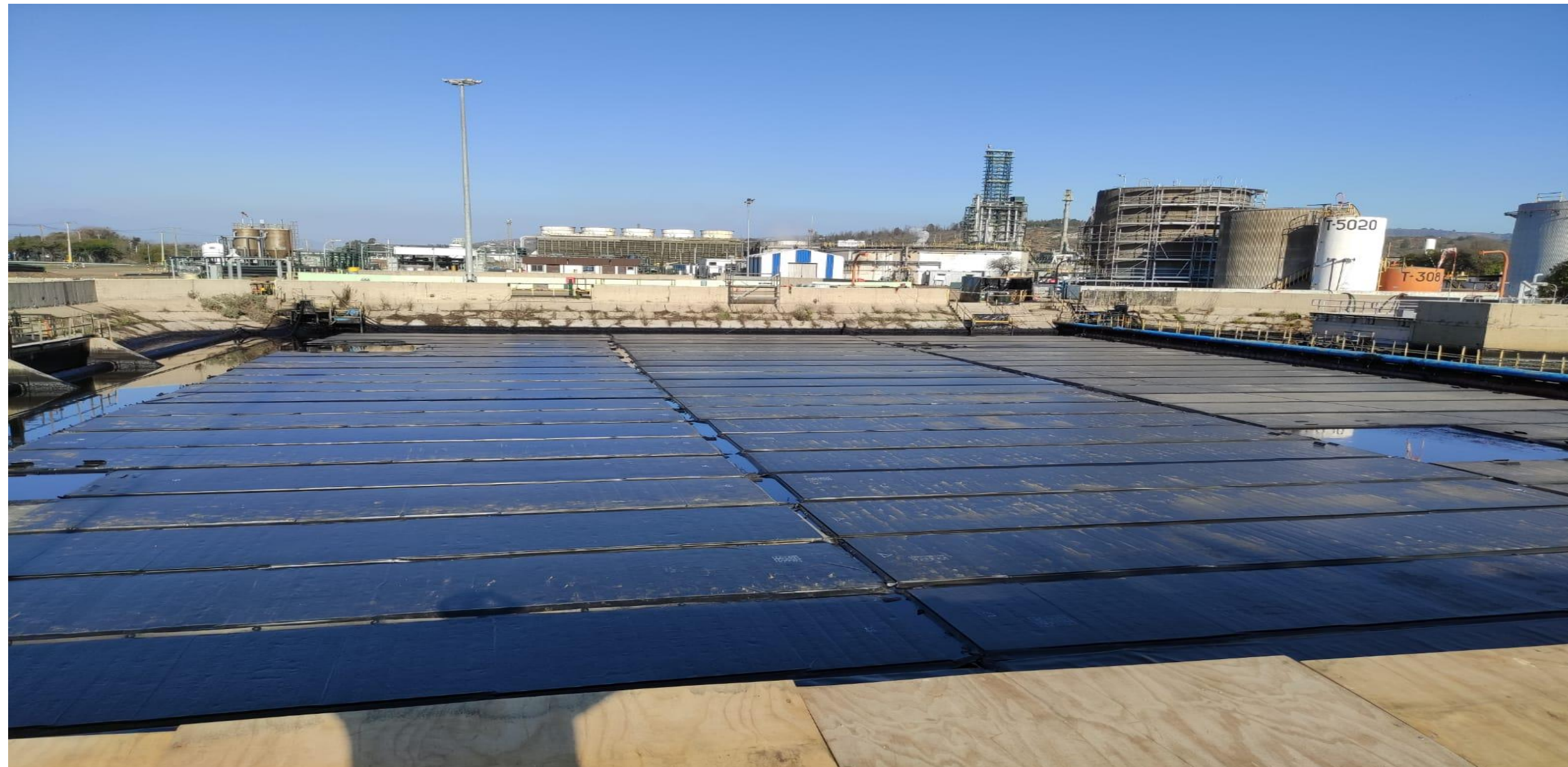
Instalación de Cubiertas Fijas (Unidad de Fenoles 2) ~ 900 m 2
