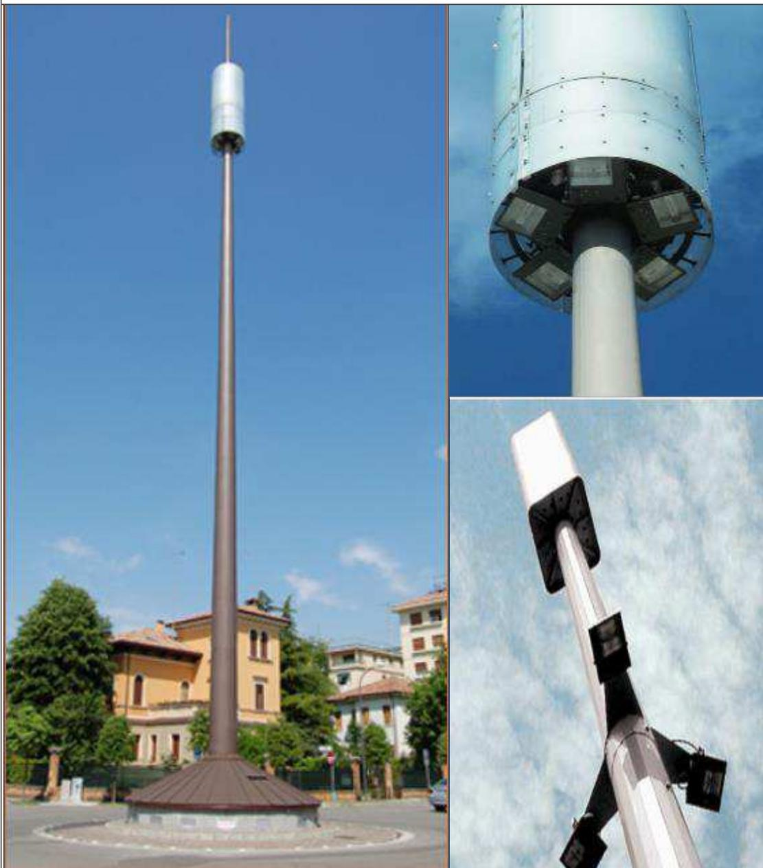
**E. MIMETIZACIÓN DE ANTENAS SOBRE ESTRUCTURAS TIPO “TRI TOWER”:****Imagen Referencial**
