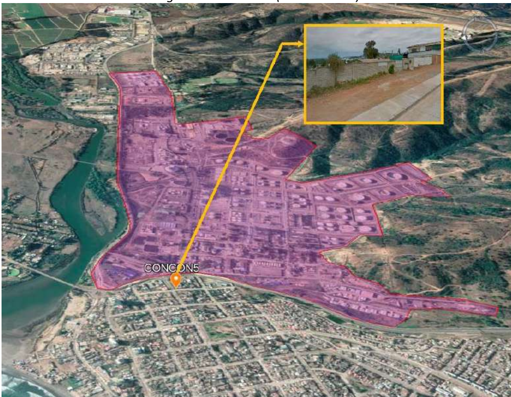
Figura 13: Concón 5 (vista oeste)
