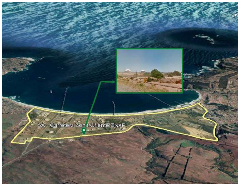
Figura 6: 5A – Carretera, Zona Oriente ENAP (vista sureste)
