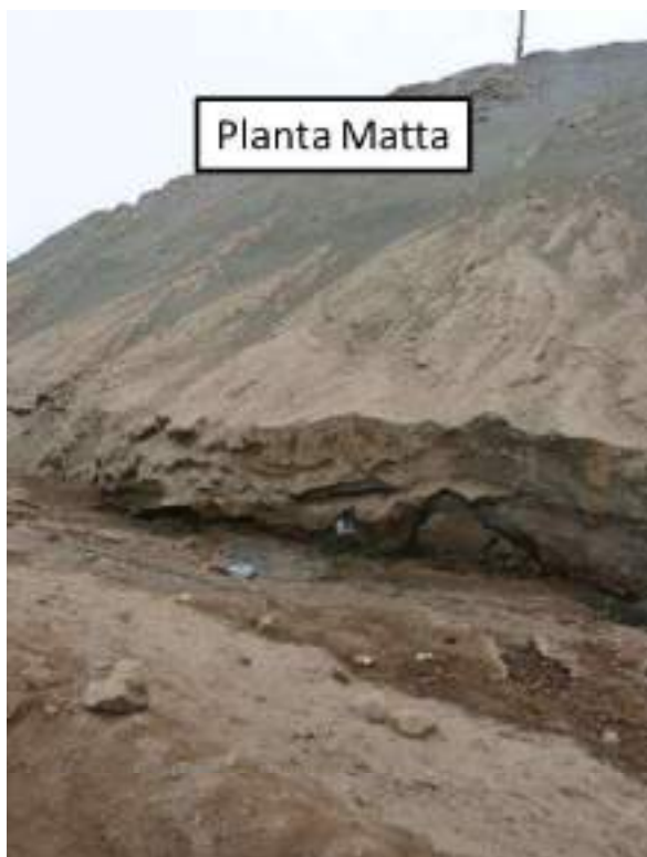
Figura 3-44: Relave Planta Matta erosionado por flujo aluvional. El flujo de los aluviones arrastró material de los relaves provocando contaminación de los sectores cercanos. A gran escala el material de relave y sus altas concentraciones fue diluido por los lodos aluvionales. Fuente: Elaboración propia.
