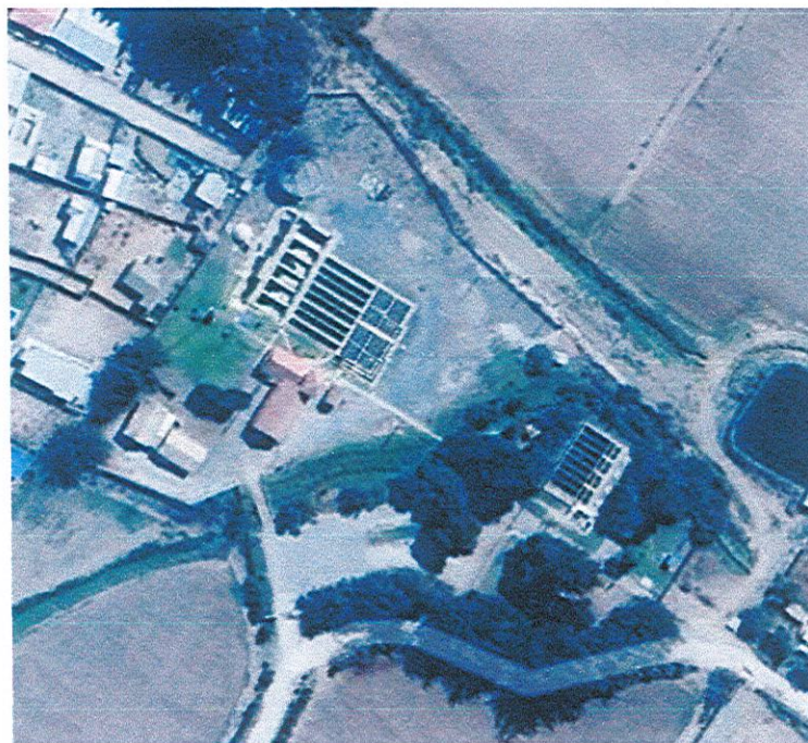
Figura N° 4.7: PTAP Las Rojas – Aguas del Valle
