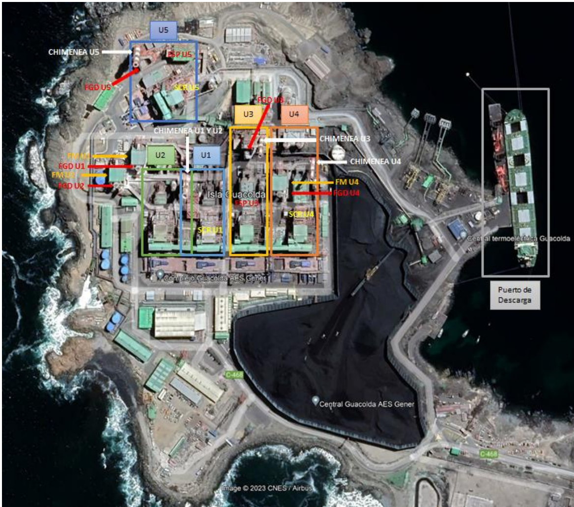
Figura 3-1 Ubicación de las unidades generadoras de Central Guacolda
