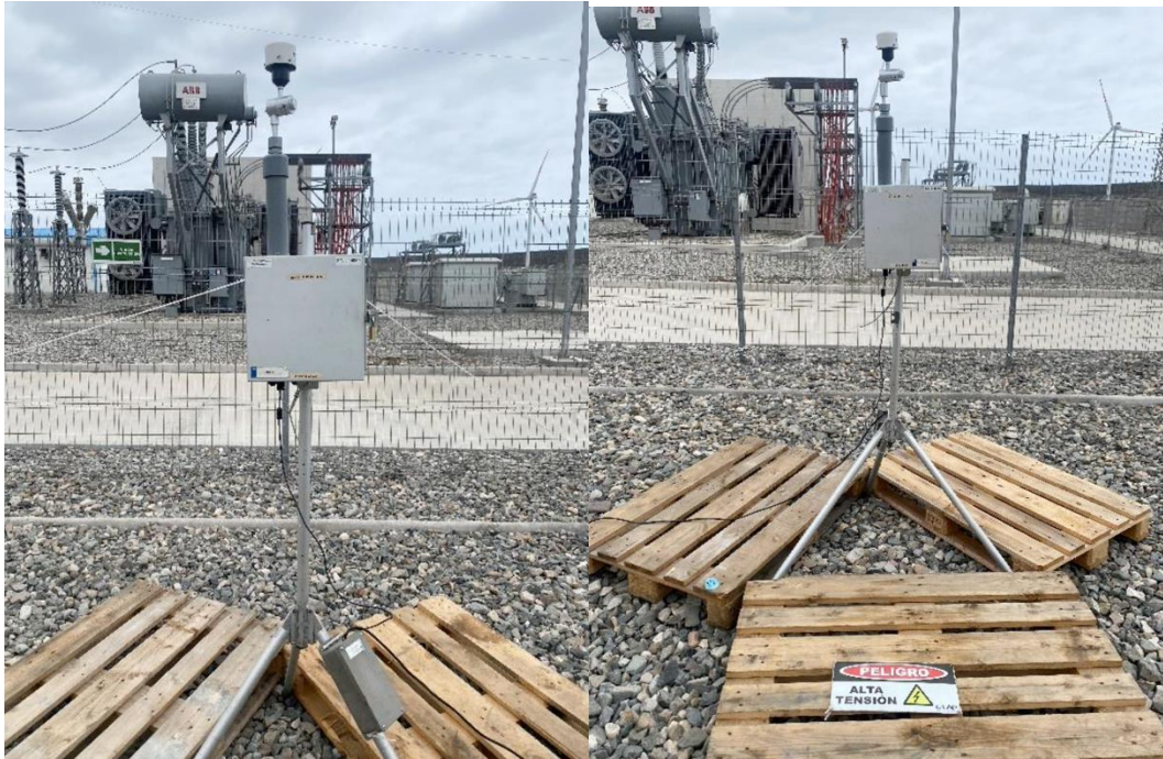
Figura 3-63 Monitores continuos instalados para medir MP10 y MP2,5 en Parque Eólico San Juan
