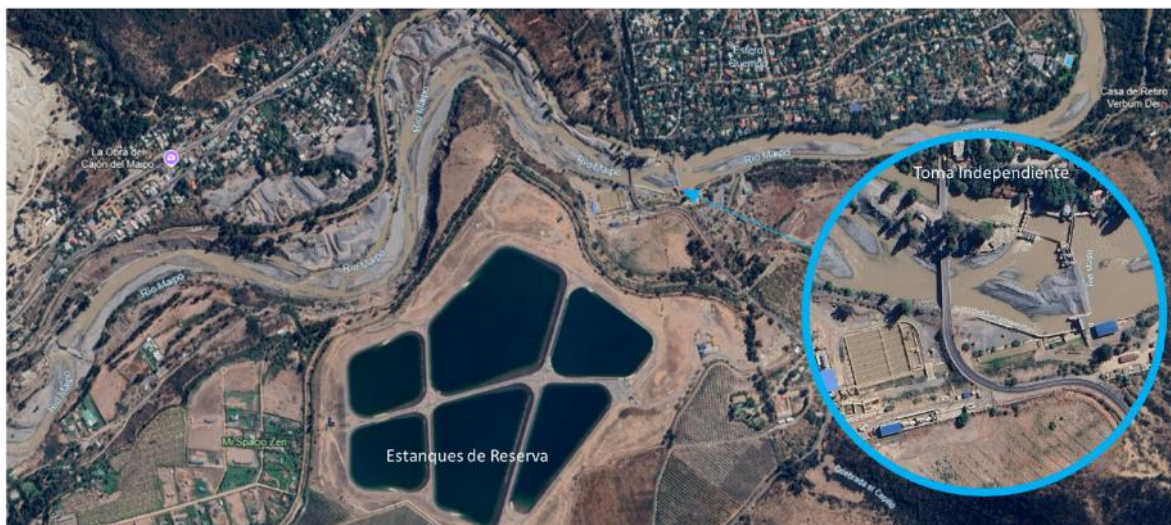
Figura 7: Toma Independiente y Estanques de Reserva de Aguas Andinas en Las Vertientes
