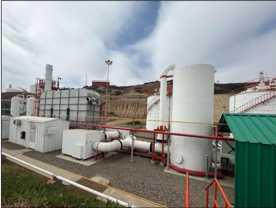
*Ilustración 3. Imagen real de la planta RTO del terminal marítimo Quintero de Oxiquim.*
