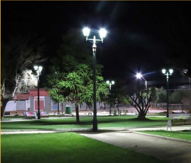
Desde una iluminación eficiente
